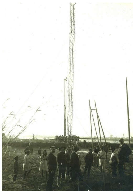
Instal·lacions de la Eléctrica del Ebro Fons Antoni Cartes Reverté
